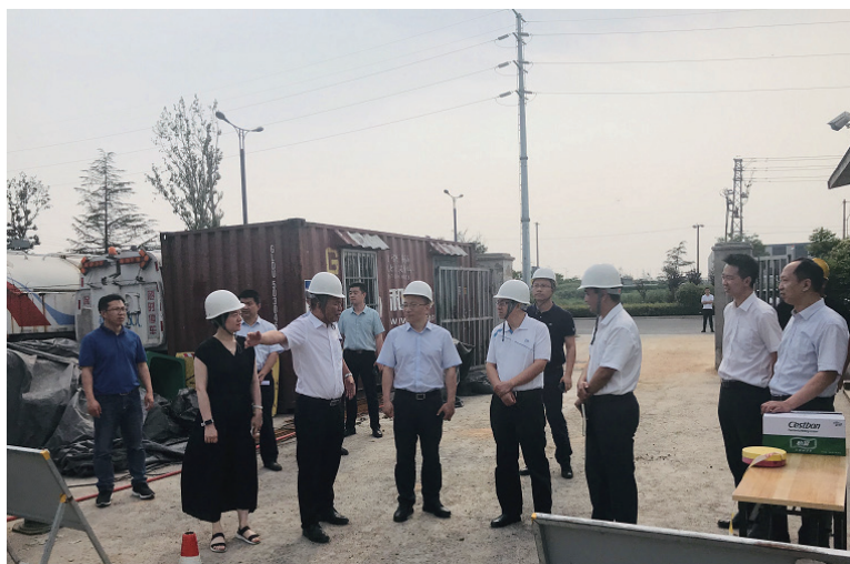
● 6月23日，省通信管理局副局长王鹏赴连云港实地督导连云港国际互联网数据专用通道建设工作
