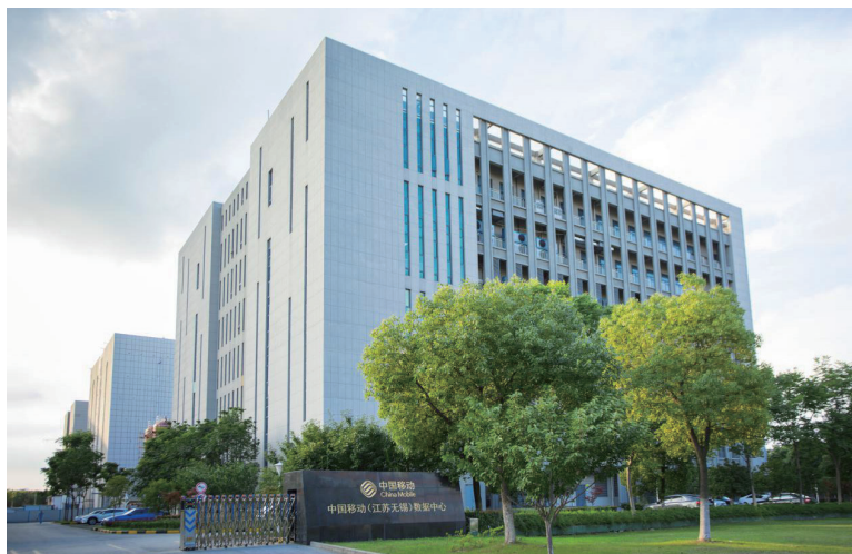
● 中国移动长三角（无锡）数据中心
