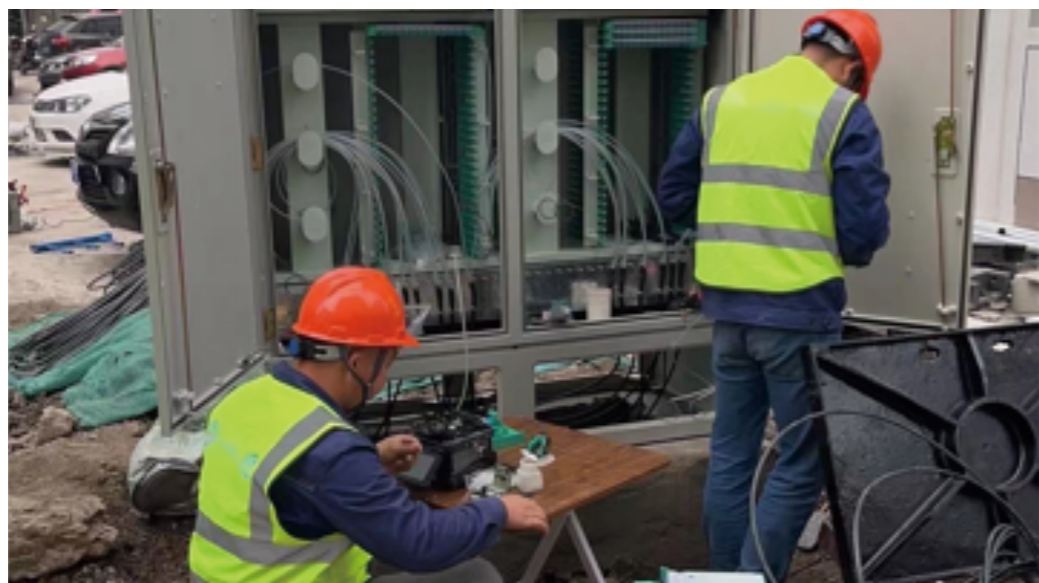
江苏铁塔持续推进“老旧小区改造工程”
