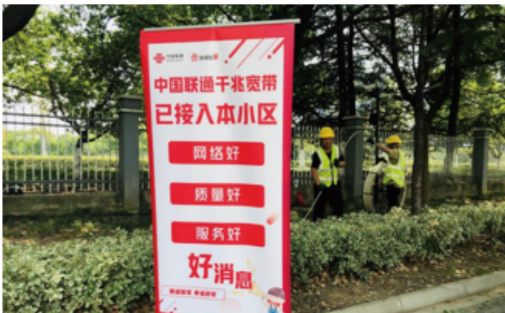
苏州吴江区小区光缆改造现场
