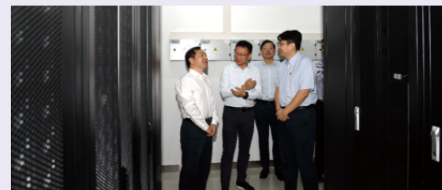
江苏省通信管理局党组书记、局长许继金先后前往江苏三家基础电信运营企业,实地检查企业数据机房等关键部位的安全管理工作
