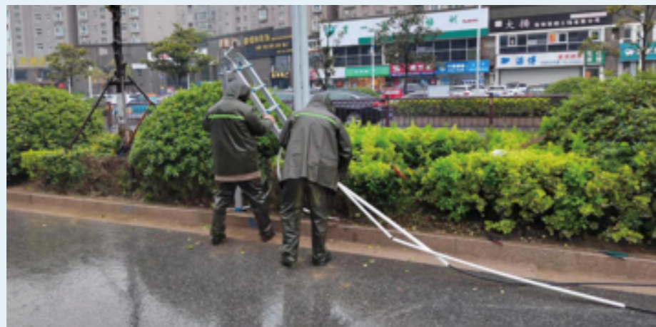
江苏铁塔信息化战疫队伍在扬州邗江区昌建广场安装防疫监控试点
