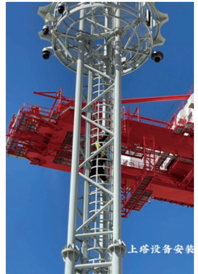
江苏联通工作人员正在上塔设备安装
