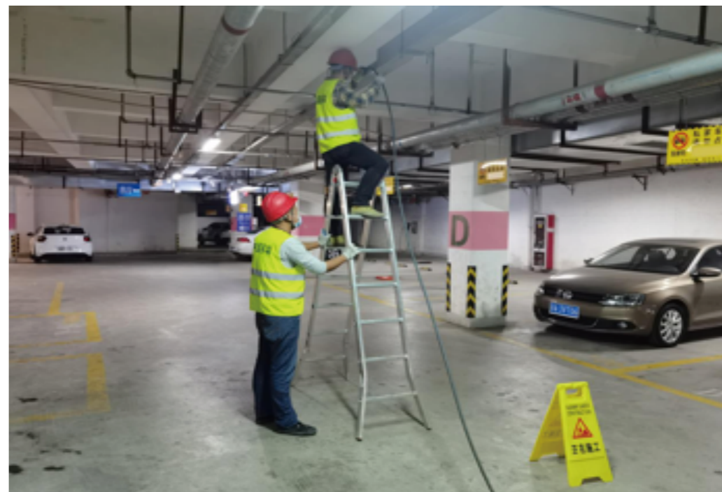
宿迁移动工作人员开展地下车库信号覆盖建设工作
